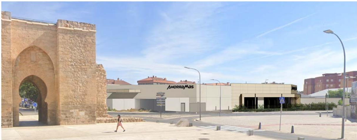
Vista general del conjunto.
