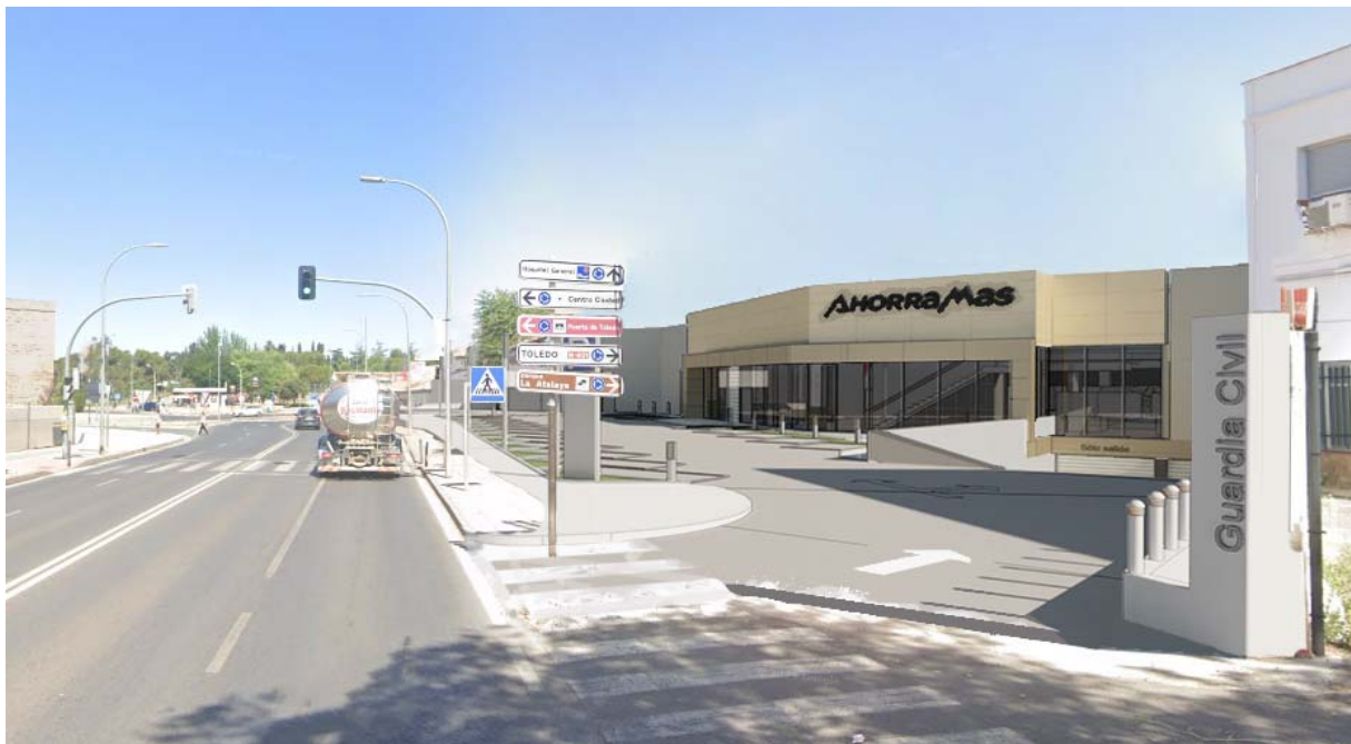
Vista del acceso desde la Ronda de Toledo.
