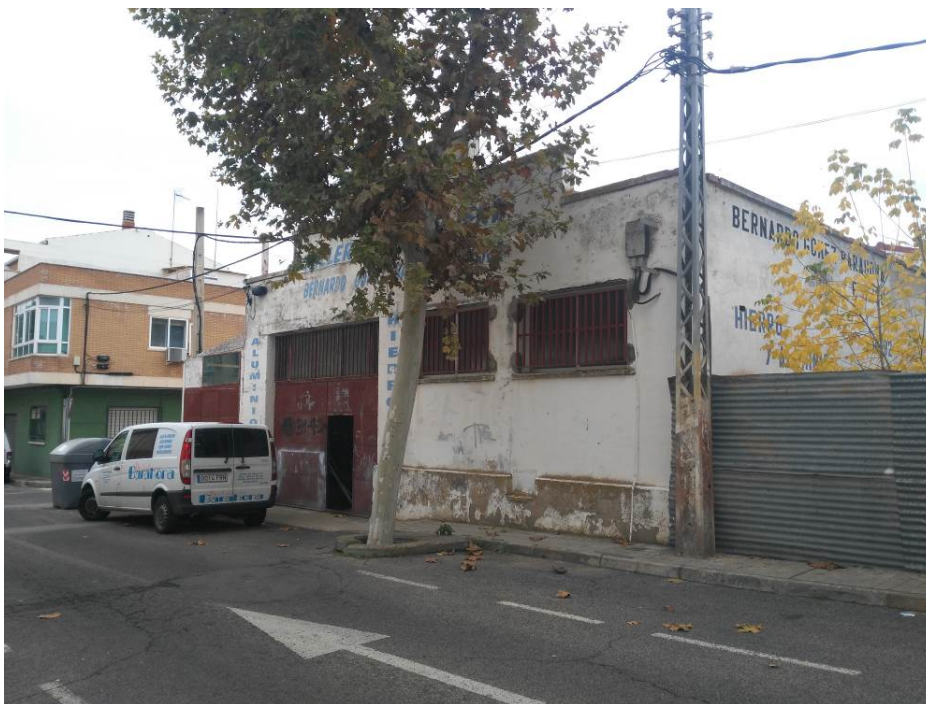
Ubicación de postes de líneas aéreas y cuadros eléctricos que limitan el espacio peatonal del acerado de la margen derecha.
