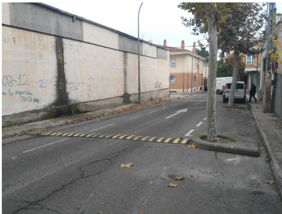
Reductor de velocidad de goma sin señalizar.
