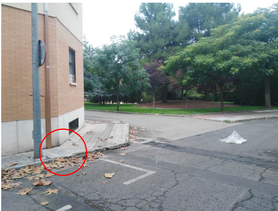
Desagües de bajantes por debajo de acerado de la promoción de viviendas existente entre las calles Juan de Vilaseca y Virgen de las Batallas.
