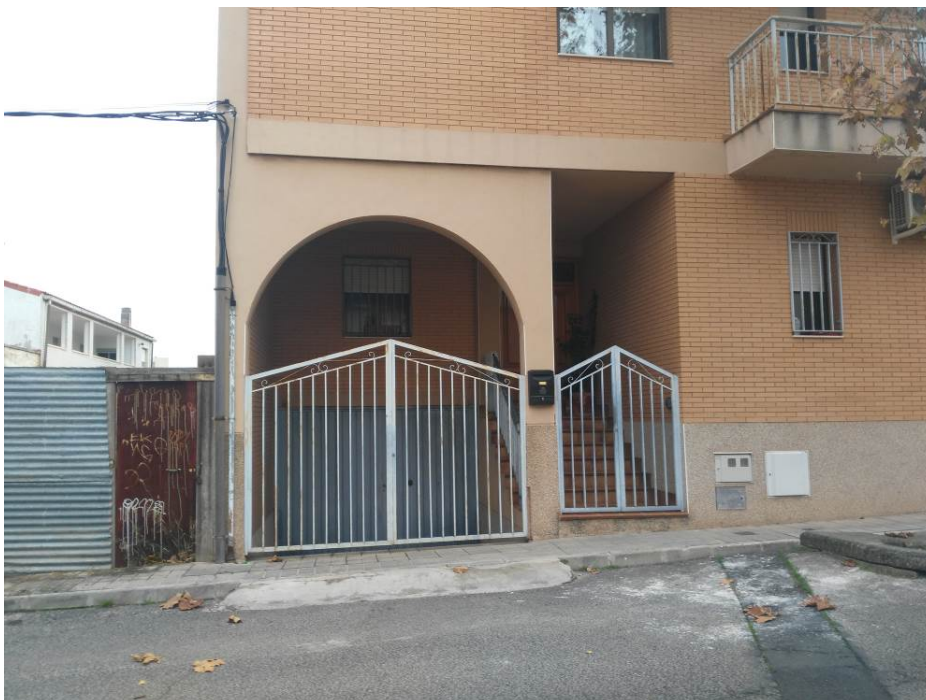
Rampas de hormigón en masa en calzada para facilitar acceso a cocheras.
