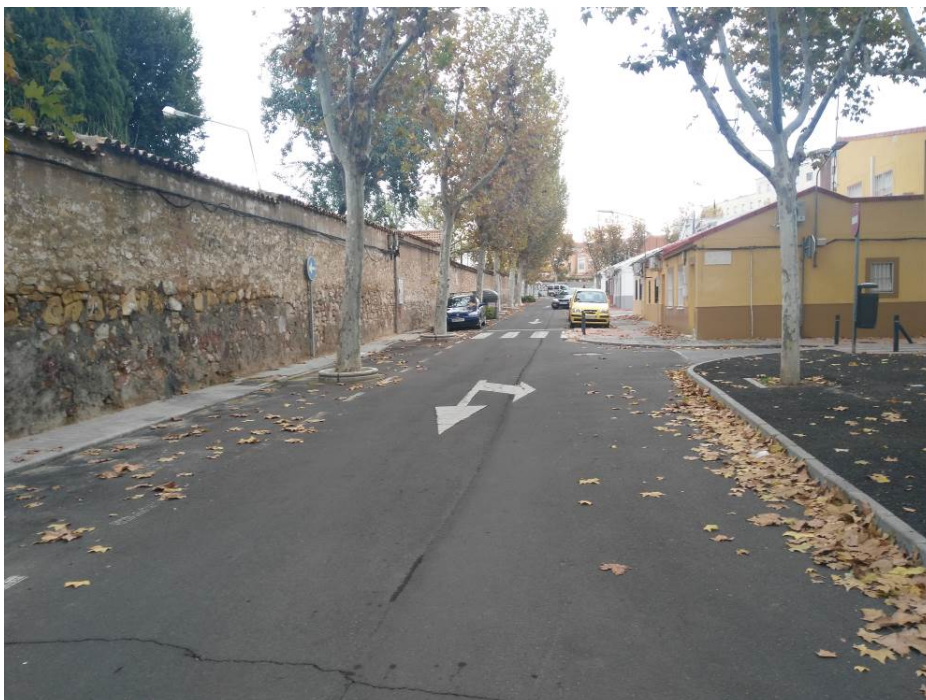
Estado de la calzada hasta calle Caballero Ramón Froilaz.
