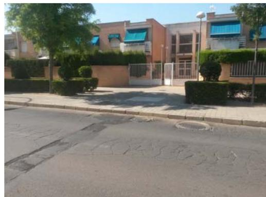
Calzada cuarteada y hundida, reposiciones del firme de zanjas descarnadas
