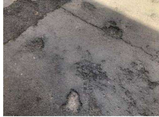
Foto 2. Baches y fisuras de la calzada
