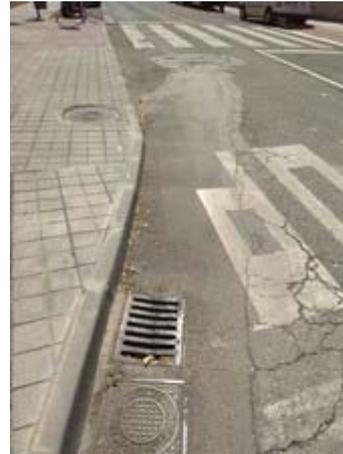
Foto 21. Zanja de la red de pluviales
