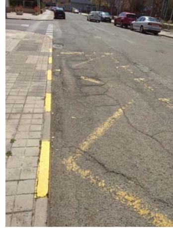
Foto 8. Cruce de zanja y fisuras
