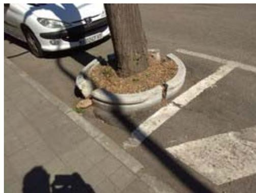
Foto 28. Alcorque y calzada levantados
