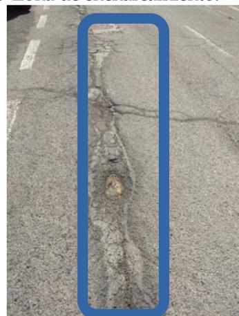
Foto 6. Zona en la que aparece el geotextil.
