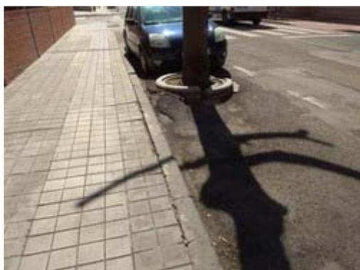
Foto 27. Acerado y alcorque levantado por raíces.
