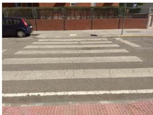
Foto 13 Paso sin línea guía en el pavimento
