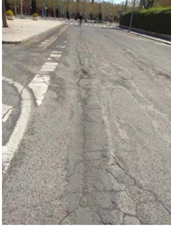
Foto 1. Deformaciones y fisuras
