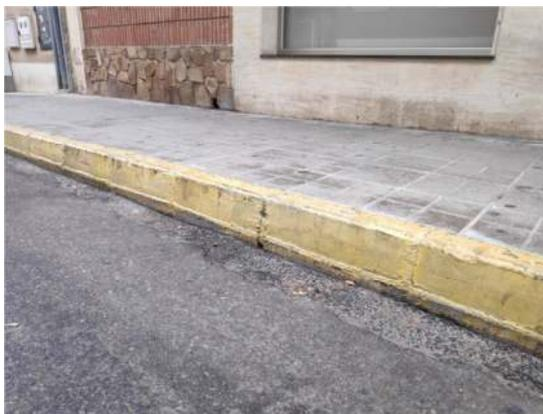
Foto 4: Bordillo hormigón de gran altura
