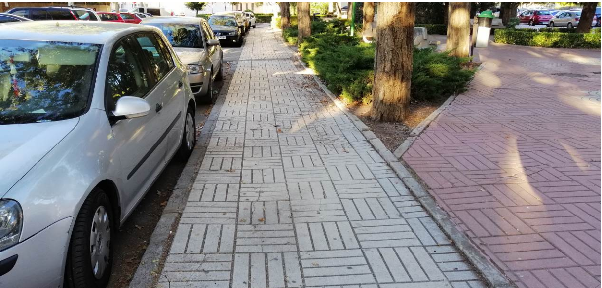
Resalto y ondulaciones en acerado de Plaza Juan XXIII.
