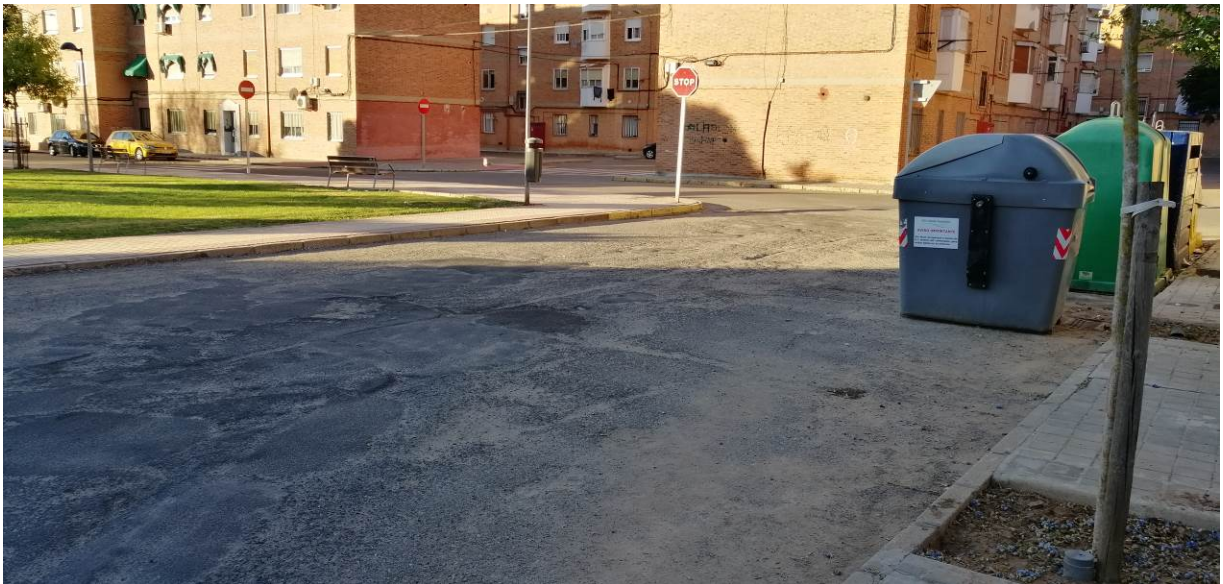
Firme disgregado y en mal estado. Calle trasera de Centro Social Pío XXII.
