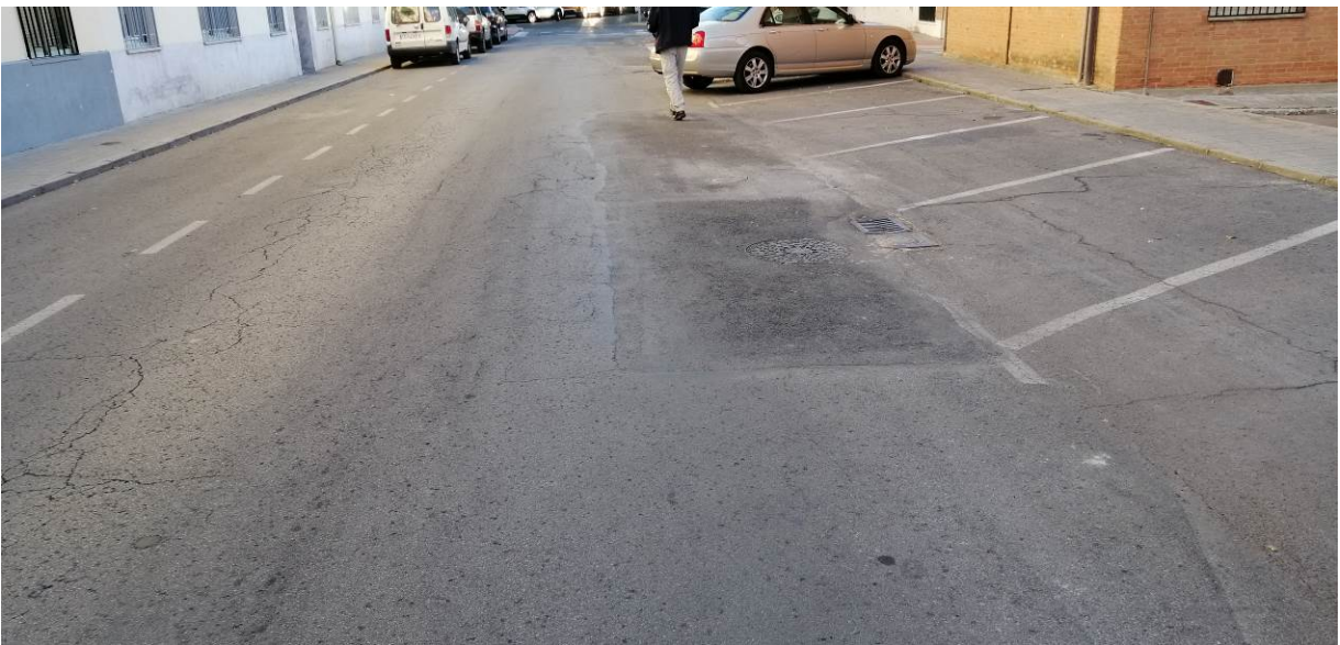
Firme en mal estado. Reposición por roturas en la red de abastecimiento de agua.
