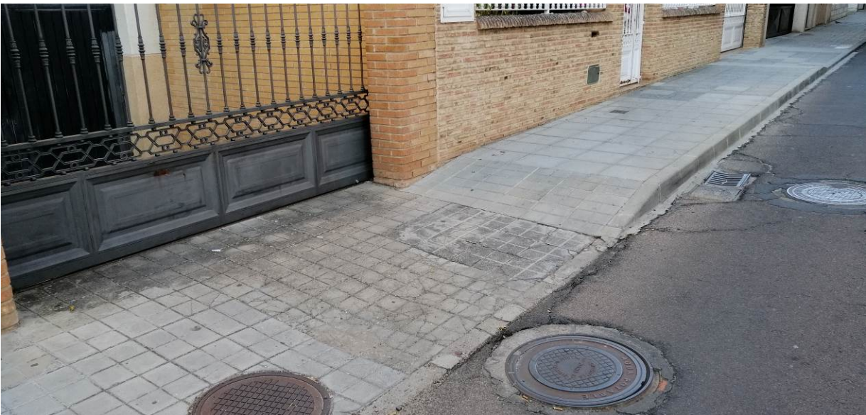
Encuentro con la calle Atalaya. Firme y pavimento en mal estado. Pendiente excesiva en el acerado en frente de acceso a garaje.
