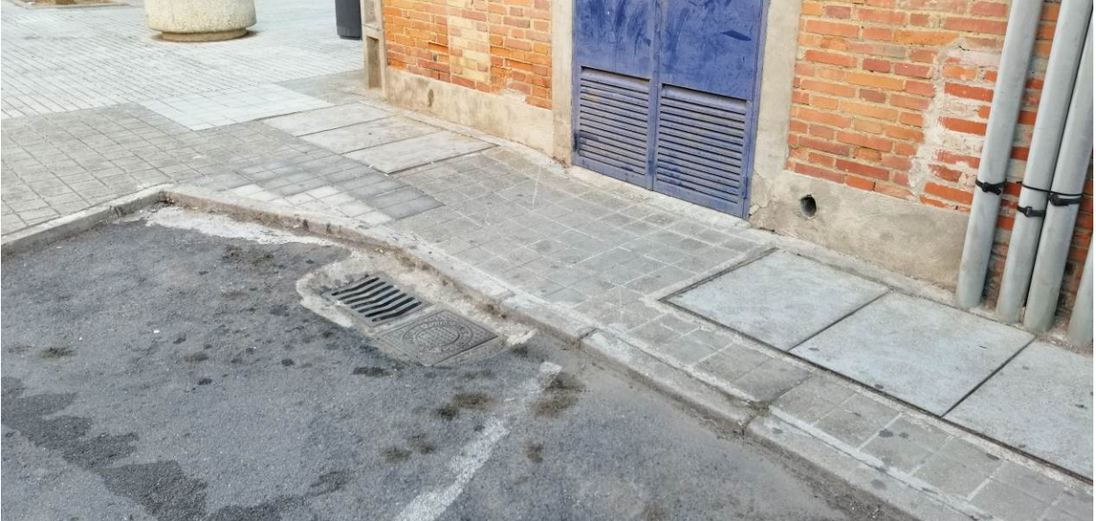
Encuentro con casetón CT Unión Fenosa. Bordillo hundido, pendiente excesiva e invertida.
