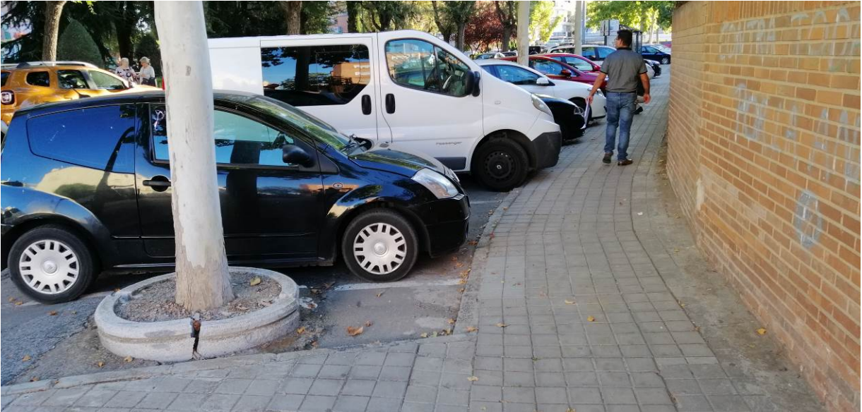
Acerado estrecho y reducido por aparcamiento en batería. Alcorques en mal estado.
