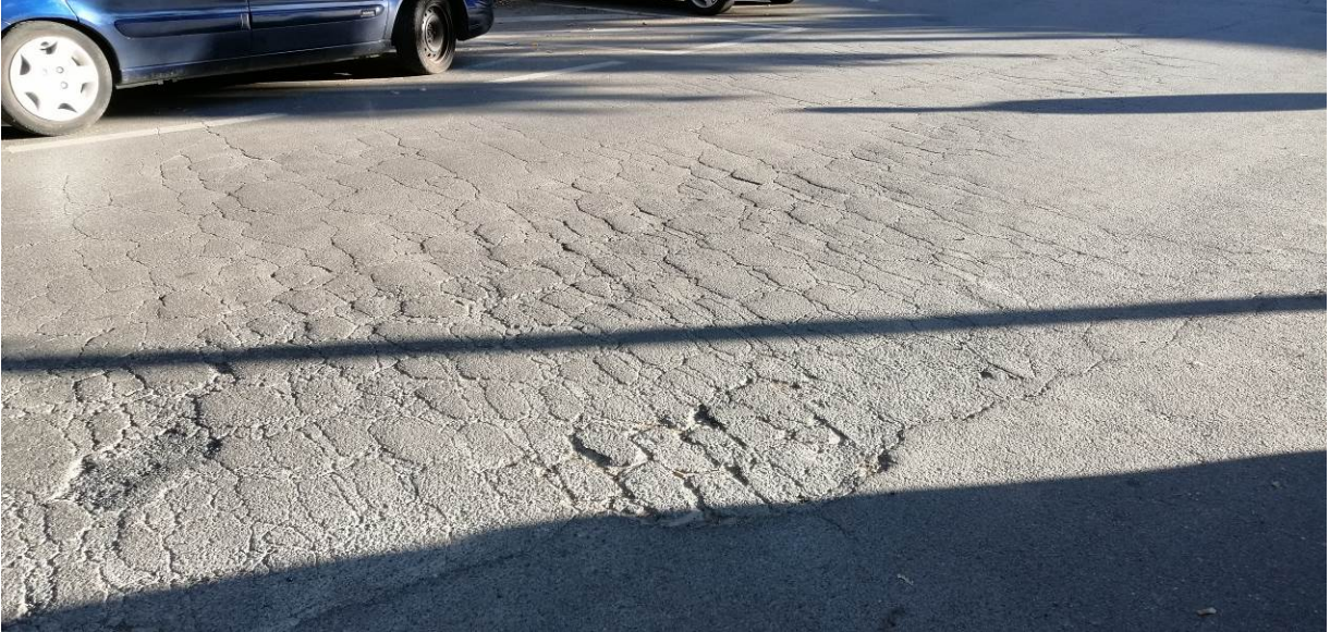
Asfaltado cuarteado en Plaza Juan XXIII. Levando de capa de rodadura.
