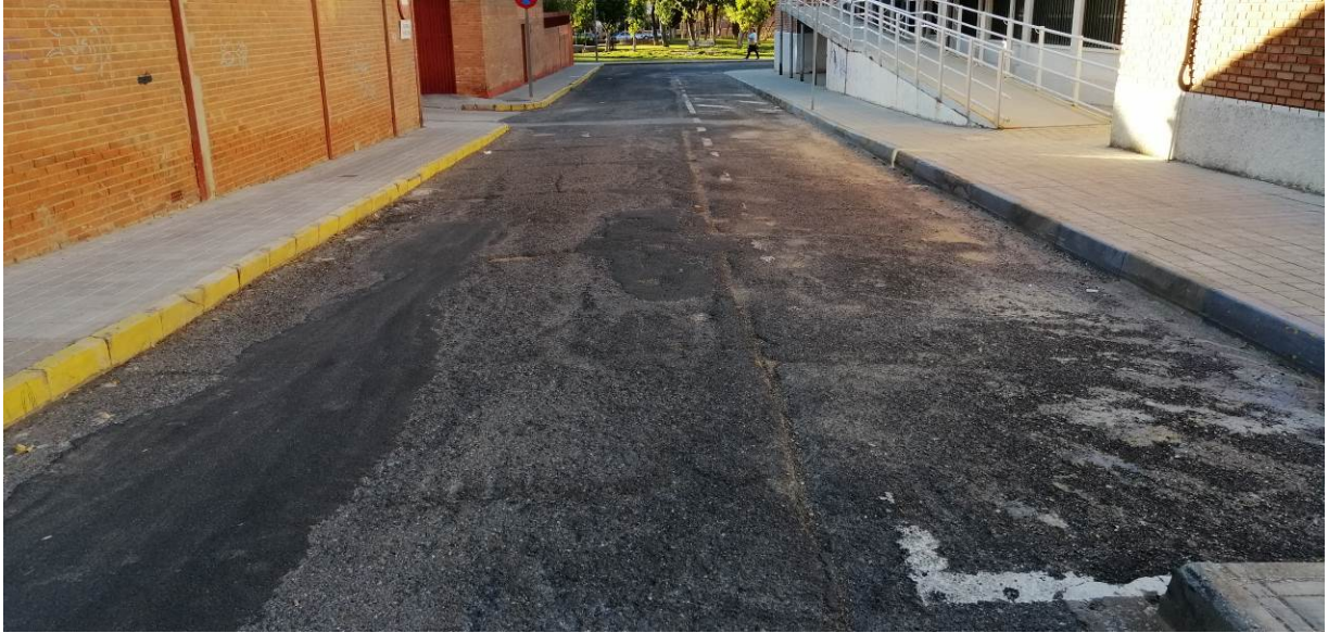
Firme disgregado y en mal estado. Calle lateral del Centro Social Pío XXII.
