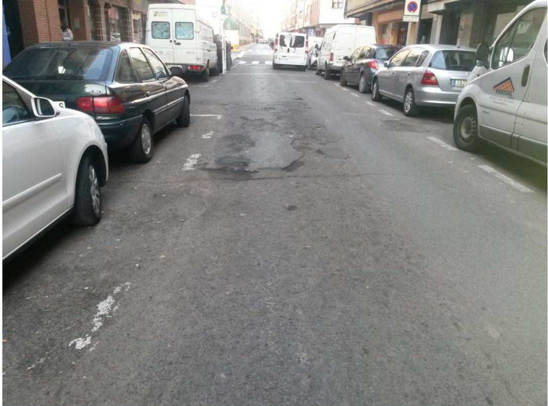
Tramo de calzada en mal estado. Se ha bacheado con aglomerado en frío y parte se ha disgregado. El deterioro también afecta a la señalización horizontal.
