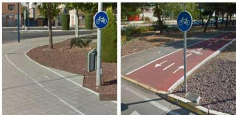
Ilustración 35. Acera-bici (imagen izquierda). Carril bici segregado (imagen derecha).
