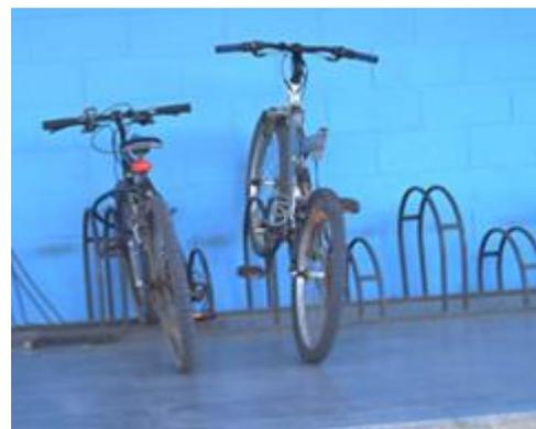
**Figura 83: Modelo de aparcabicis de soporte de ruedas. Fuente: DOYMO.**
