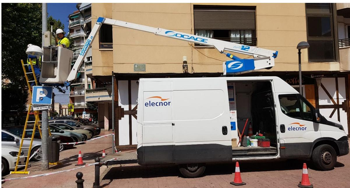
**Ilustración 6.** Ejemplo de instalación de estación de monitorización en báculo de alumbrado público.
