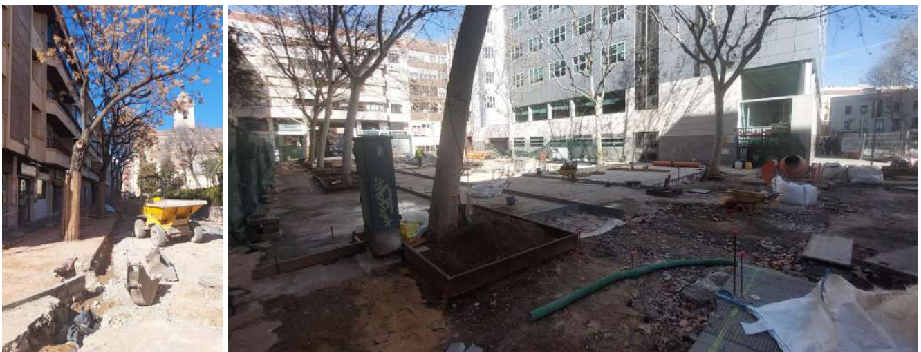
Obras llevadas a cabo a principios del 2025 en la zona centro de Ciudad Real.
