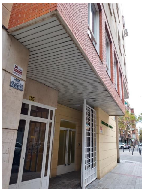
Vista exterior c/ Calatrava
