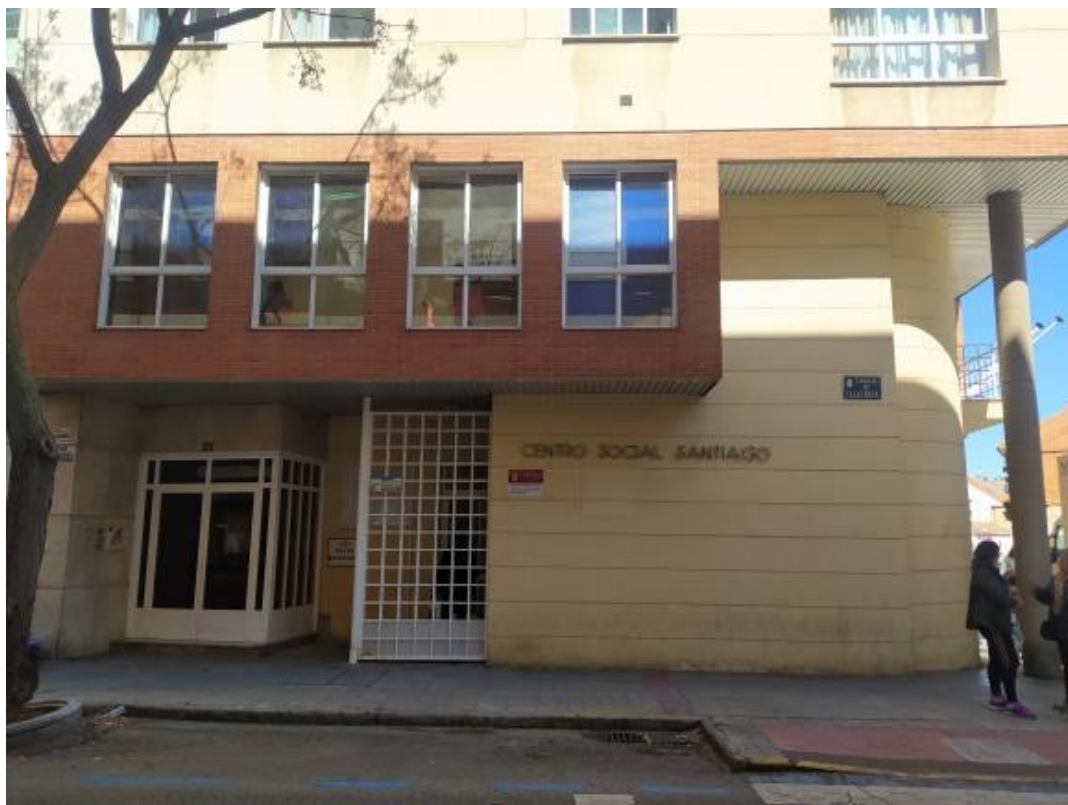
Vista exterior c/ Calatrava
