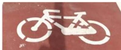
Foto de marcas viales del carril bici sobre slurry rojo.
