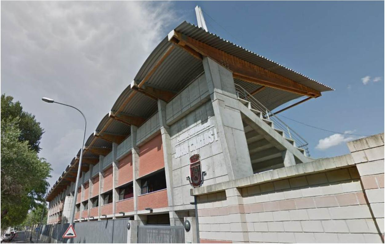
El diseño de la estructura dificulta la recogida y evacuación de las aguas de lluvia. Por un lado, el pilar metálico y los tres tirantes interrumpen el canalón, por otro, los sumideros no tienen protección y la falta de accesibilidad impide el mantenimiento y la limpieza, por último, las bajantes están empotradas en las pilastras de hormigón de cada pórtilo, lo que complica la solución de sellado y estanqueidad e impide su mantenimiento y limpieza.
